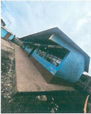
POR EL DESGASTE DE EL TIEMPO ES NECESARIO REEMPLAZAR LA PINTURA DE INTERIOR Y EXTERIOR DE ESTAS TRES AULAS
